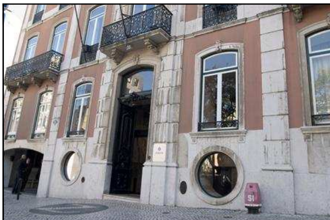
O Edifício Zurich, situado no emergente centro financeiro da cidade de Lisboa, Rua Barata Salgueiro, simboliza a nossa vontade de crescer com os olhos postos no mundo
